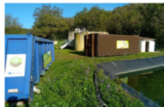
Benne étanche d'homogénéisation des boues au premier plan et centrifugeuse pour la déshydratation des boues au second plan Centrifugeuse
