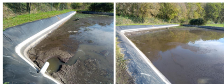
Vues sur la lagune de décantation après la fin de l'opération.
